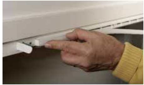
THERMOMAX VENTTIILIN SUODATTIMEN VAIHTO
