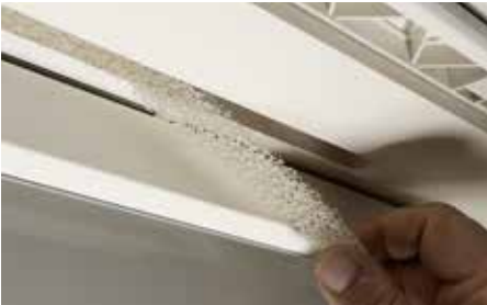
VÄLITILAN SUODATTIMEN IRROITUS / ASENNUS
