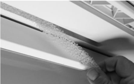
VÄLITILAN SUODATTIMEN IRROITUS / ASENNUS
