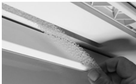
VÄLITILAN SUODATTIMEN IRROITUS / ASENNUS
