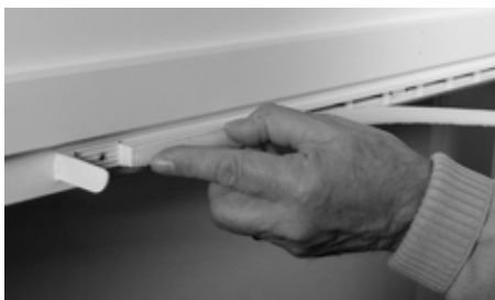
THERMOMAX VENTTIILIN SUODATTIMEN VAIHTO
