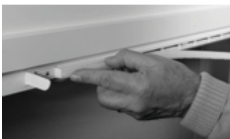
THERMOMAX VENTTIILIN SUODATTIMEN VAIHTO
