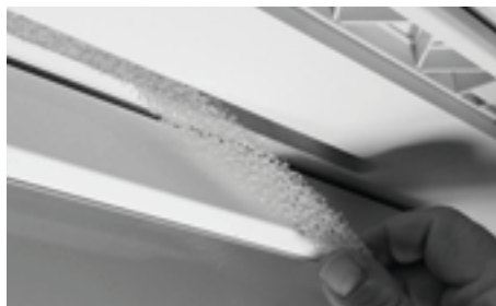
VÄLITILAN SUODATTIMEN IRROITUS / ASENNUS
